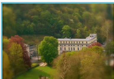
Castel de Pont-à-Lesse
